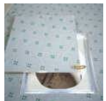
Eingebaut im Büro (Putzschacht), ausgelegt mit Teppich
